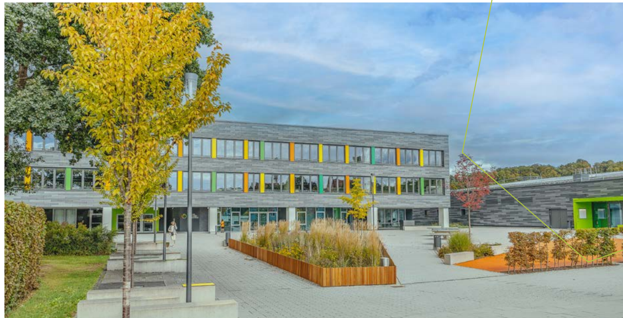
Die Walter-Höllner-Realschule in neuem Gewand – generalsaniert, modern und zukunftsorientiert.
